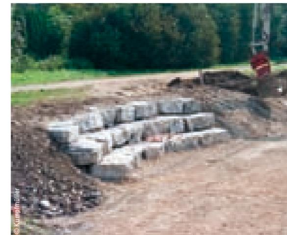
Die Geländemodellierung und das Versetzen der Steine für die Sitzstufen gehört zu den ersten Arbeiten.
