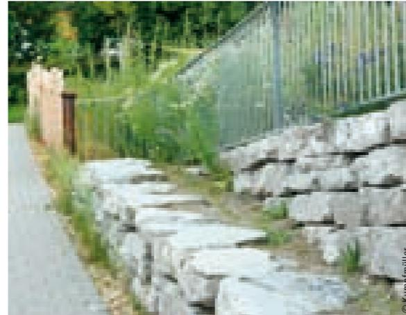
Stabil geschichtete Trockenmauer aus grauem Kolomaner Schichtkalk.
