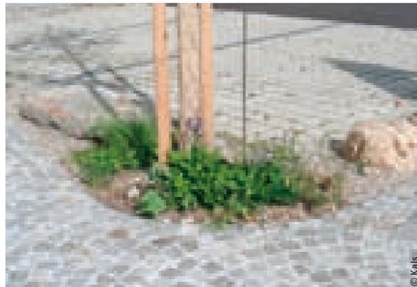
Granitpflaster für den Zugang, Betonpflaster mit breiteren Fugen für den Parkplatz. Die ersten Pflanzen zeigen sich bereits nach ein paar Wochen
