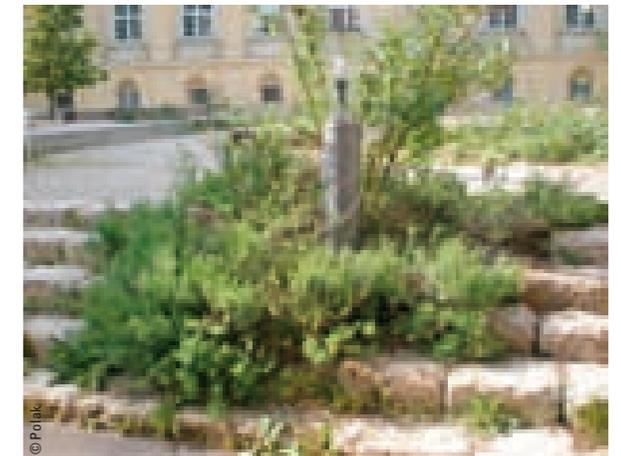
Kalkblöcke in ungebundener Bauweise als Stufen. Dazwischen gedeihen Pflanzen, die trockene, sonnige Standorte bevorzugen.
