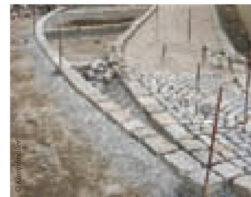
Die Qualität einer Pflasterfläche wird vor allem von drei Komponenten bestimmt: Steinmaterial, Steinformat und -größe und Verlegungsart. Aus naturschutzfachlicher Sicht bieten größere Steinformate (z.B. 16x16x16 cm) aufgrund der tieferen und breiteren Fugen die besten Voraussetzungen für die Entwicklung vielfältiger Fugenvegetation. Hinsichtlich des Gesteins sollte heimischem Material der Vorzug gegeben werden.
