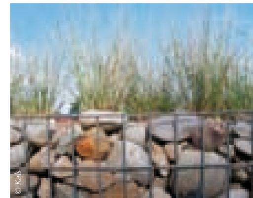
Eine Begrünung von Gabionen ist grundsätzlich möglich. Dafür muss zumindest in Teilen der Körbe anstelle der üblicherweise verwendeten groben Körnungen bewuchsfähiges Feinmaterial eingebracht werden.
