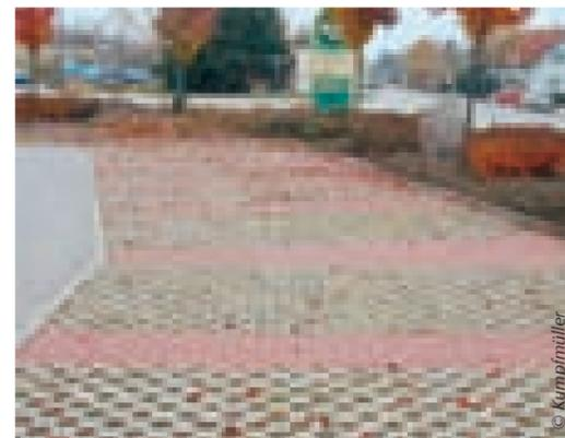
**Radwege** müssen homogene Oberflächen aufweisen und gleichzeitig auch bei Nässe rutschfest sein. Vor allem Betonpflaster erfüllt diese Anforderungen. Aus Gründen der Verkehrssicherheit ist eine konsequente eigene Farbgebung (vorzugsweise rot) wünschenswert, was entweder durch aufgebraute Farbschichten oder farbige Pflastersteine erreicht werden kann. In Parks oder auf Nebenrouten können auch wassergebundene Decken verwendet werden.
