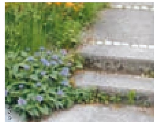
Bei Stiegen an Gebäuden oder wenn örtlich vorhandenes kleinteiliges Steinmaterial verwertet werden soll, können gebundene Bauweisen die bessere Wahl sein. Durch Verwendung von wasserdurchlässigem Splittbeton, Schaffung strukturierter Oberflächen, zurückversetzte Fugen und Aussparung von Pflanzlöchern können auch an gebundenen Treppen interessante Lebensräume entstehen.
