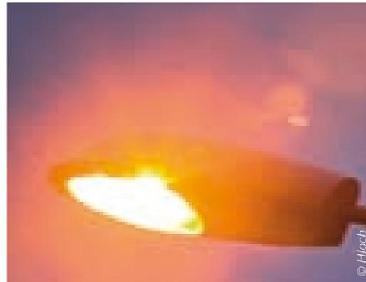
» Geschlossene, nach oben abgeschirmte Leuchte mit Natriumdampflampe
