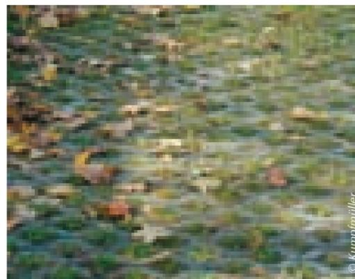
Als Dränpflaster werden Betonpflaster bezeichnet, die durch seitliche Abstandhalter bei der Verlegung eine Mindestfugenbreite von 1 bis 3 cm gewährleisten. Die mit Sand verfüllten Fugen bieten eine gute Voraussetzung für eine Begrünung.
